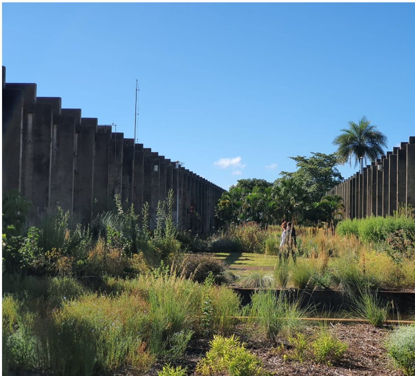
Vão Central do ICC-Sul com o Jardim de Sequeiro Florido em Mar 2021. Foto: Julio Pastore.
